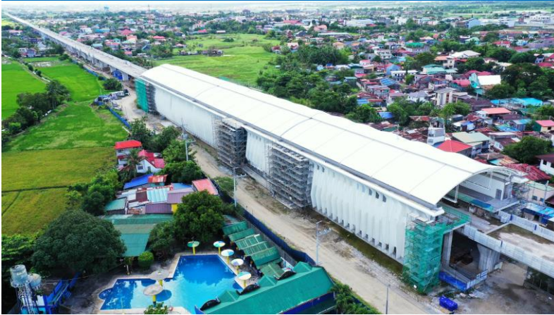
南北通勤鉄道 建設中の駅の様子
